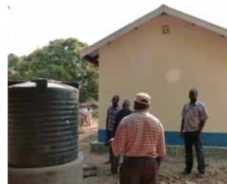
Die Bewohner der Dörfer leisten ihren Beitrag zu den Baumaßnahmen.
