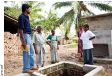
In 46 Dörfern entstehen Haushaltslatrinen sowie Sanitäranlagen für Schulen und Gesundheitseinrichtungen.
